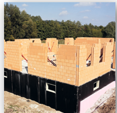
Ein Geschoss samt Decke kann innerhalb eines Tages fertiggestellt werden
