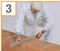
In die noch feuchte Mörtelschicht wird die erste Ziegelschar nach herkömmlicher Art versetzt. In dieser Phase ist äußerste **Genauigkeit** erforderlich.
