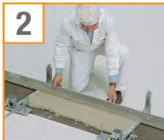
Ausgehend von diesem **höchsten Punkt des Fundamentes** bzw. der Bodenplatte legen Sie ein vollflächiges Mörtelbett für die erste Ziegelschar an, das mindestens 1,5 cm stark sein muss. Das Planfix-Justiergerät ermöglicht ein millimetergenaues Abziehen mit der Messlatte zwischen den beiden Teilen des Justiergerätes.
