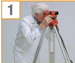
Mit einem Nivelliergerät oder Laser ermitteln Sie den höchsten Punkt des Fundamentes bzw. der Bodenplatte. Legen Sie in der Breite des Mauerwerkes eine **Bitumenbahn** auf.
