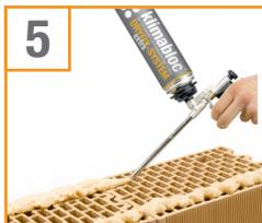
Vor dem Auftragen der Klebekomponente – durch ein geschultes Personal – hat eine gründliche Säuberung (Staubfreimachung) der Klebefläche zu erfolgen. Auf die in Punkt 3 hergestellte nivellierte (plane) Schar werden nun 2 Klebestränge mit ca. 2 cm Ø aufgetragen und zwar parallel in einem Abstand von 5 cm zur Ziegelwandaußen- bzw. -innenseite.
