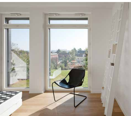
Einseitige Fensterlüftung mittels Oberlichtern Foto: Adam Mørk
